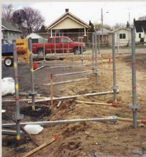
Šroubové úvodní úseky byly instalovány. Prodloužení s hlavní posuvnou deskou jsou připraveny pro zavedení injektážního pažení.
