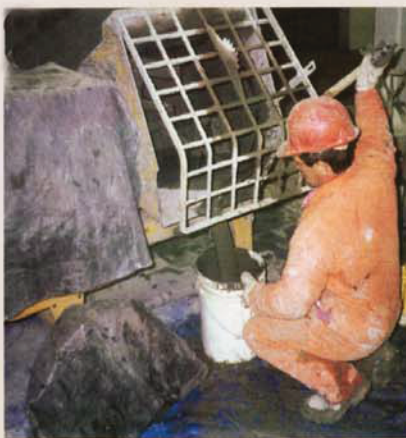
Míchání injektáže a její přidání k mikropilotě.
