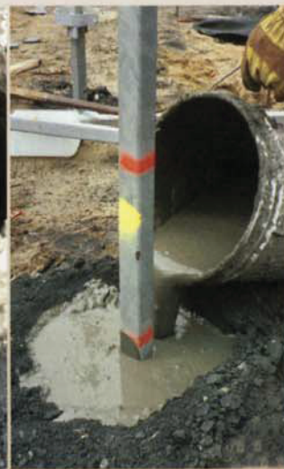
Mikropilota se dolije injektáží.
