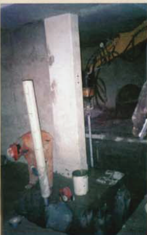
Přidání prodloužení aby se dosáhlo základové hloubky a instalace opravné podpěry. PVC obal minimalizuje negativní síly spodního tlaku.
