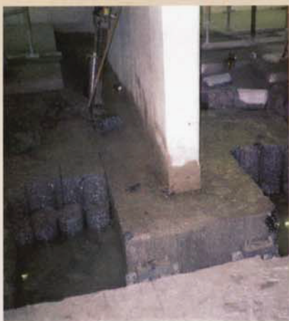
Příprava základů pro šroubové vrtané mikropiloty.
