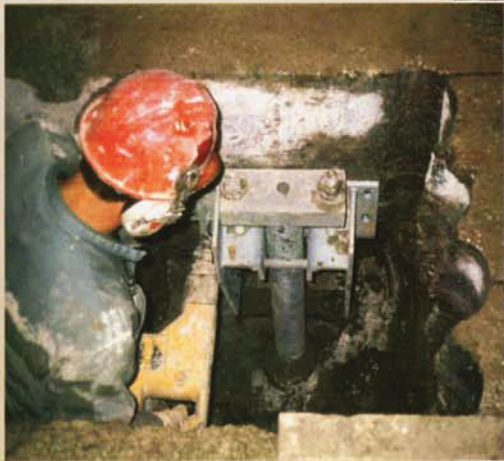
Přidání prodloužení aby se dosáhlo základové hloubky a instalace opravné podpěry. PVC obal minimalizuje negativní síly spodního tlaku.
