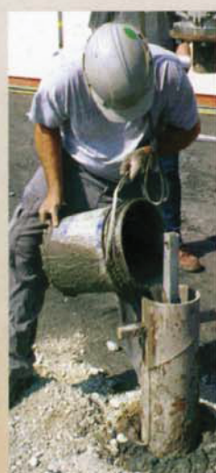
Přidání injektáže do pažení.
