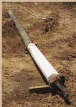
Šroubové vrtané mikropiloty vytažené pro vizuální kontrolu
