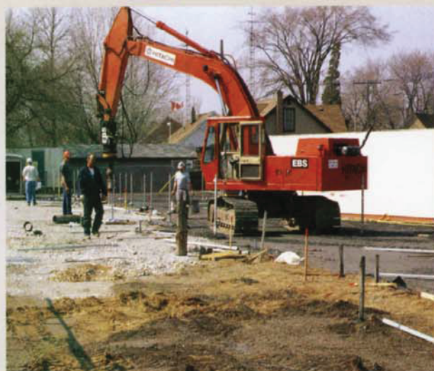
Rypadlo s momentovým motorem zavádí řadu šroubových vrtaných mikropilot k podložení nové budovy.
