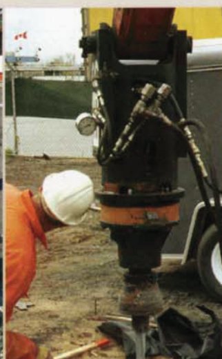
Monitorování točivého momentu během instalace ověří únosnost.
