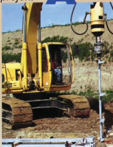
Instalace (4) šroubovicového úvodního úseku.
