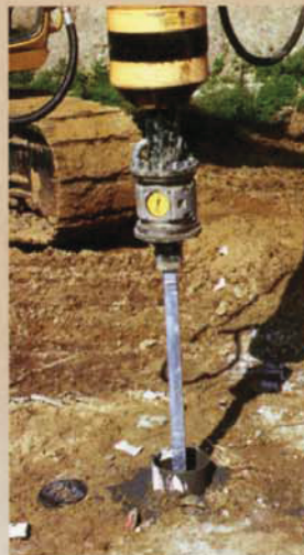
Instalace přídatného prodloužení skrz PVC pažení.
