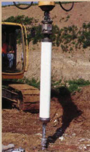
Instalace prodloužení pomocí hlavní posuvné desky a PVC injektážního pažení.
