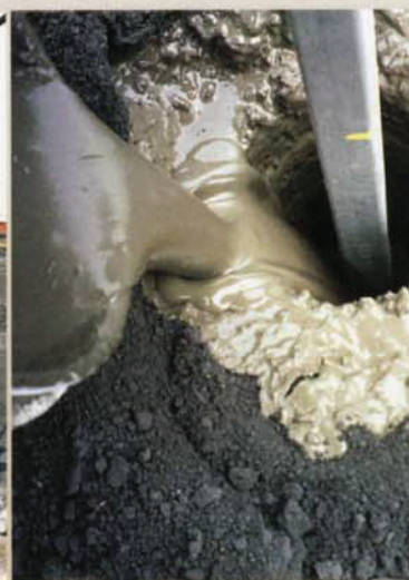
Šroubová vrtaná mikropilota je posuvná pilota, která vytlačí půdu kolem osy. Prázdný prostor je vyplněn injektáží.
