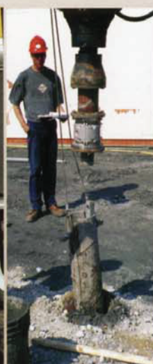
Vytažení injektážního pažení po dosažení určeného točivého momentu.
