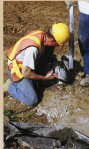
Seříznutí prodloužení do požadované výšky.
