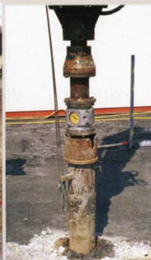
Instalace injektážního pažení.
