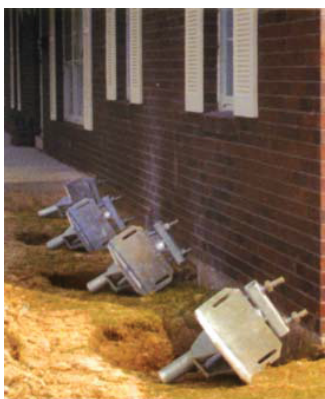
Nástavce šroubových pilot jsou odpojeny a následně jsou připevněny příruby
