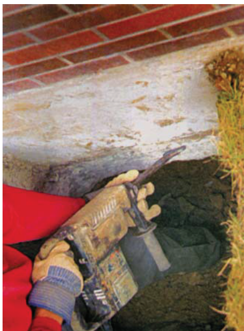
Vysekání zářezu v základech pro upevnění příruby
