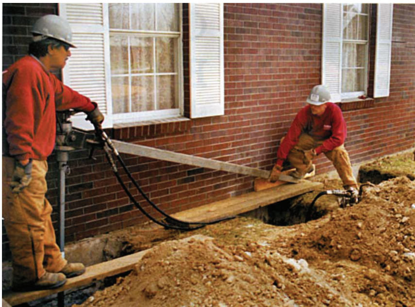
Instalace šroubových pilot pomocí hydraulického zařízení
